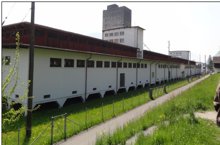
Abb. 5: Getreidespeicher (Quelle: Remund+Kuster, 2011)
