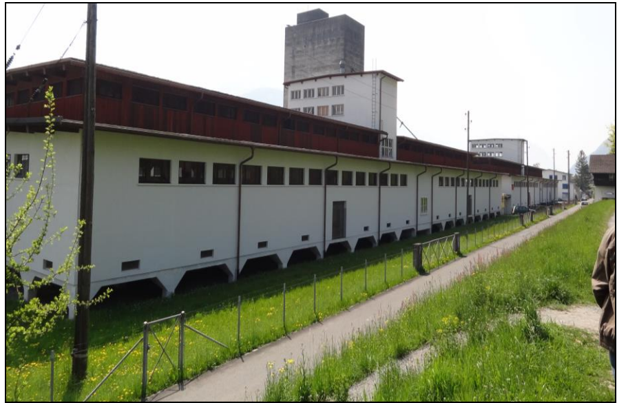
Abb. 5: Getreidespeicher (Quelle: Remund+Kuster, 2011)
